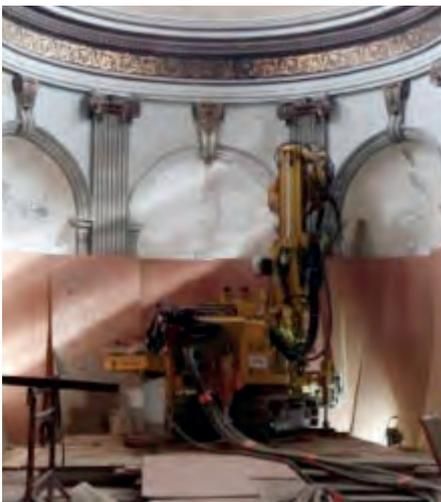
Des micropieux ont été forés de part et d'autre des fondations des murs du chœur et de la sacristie, permettant de soutenir ceux-ci et ainsi d'arrêter le phénomène de basculement de l'édifice.
